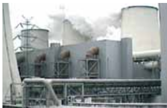
Inspection de l'isolation
